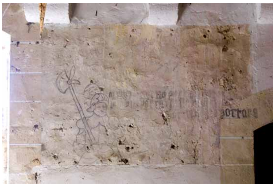
Fig. 14 : Morlanne, maison Belluix, premier étage (Cl. P. R., 2007).
