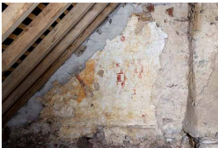
Fig. 4 : Neau, pignon occidental, détail (cl. Inventaire F. Lasa).
