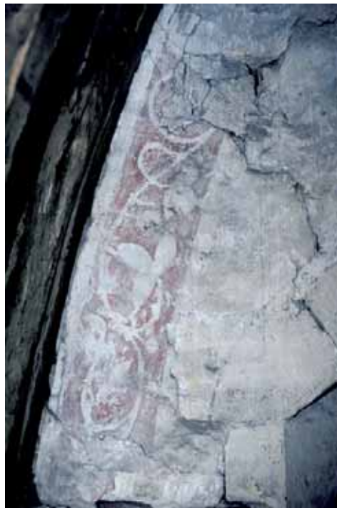
Fig. 10 : Frise de rinceaux, XIV e siècle, maison, mur est, 5, impasse Prud'homme, Bayeux (cl. V. Juhel, avril 1996).
