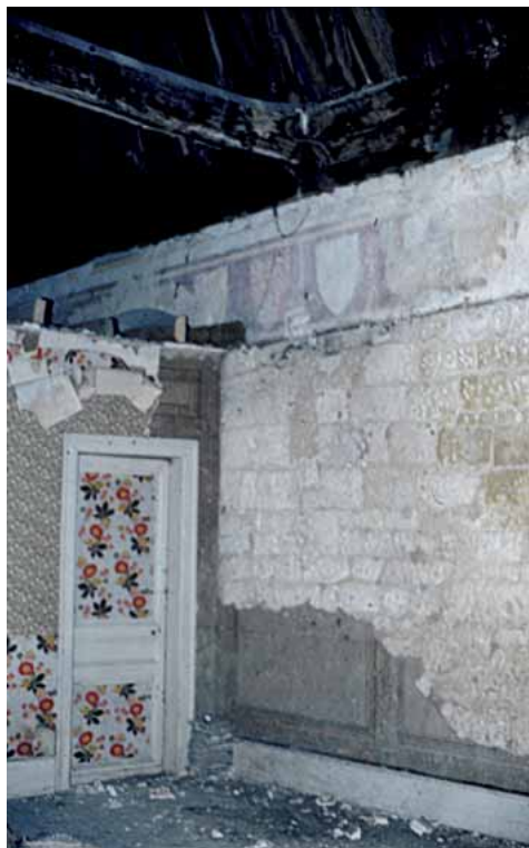
Fig. 6 : Frise héraldique, XIV e siècle, manoir de la Vigne, état en cours de travaux de dégagement du volume médiéval, Le Mesnil-sous-Jumièges (Seine-Maritime) (cl. V. Juhel, juin 1991).
