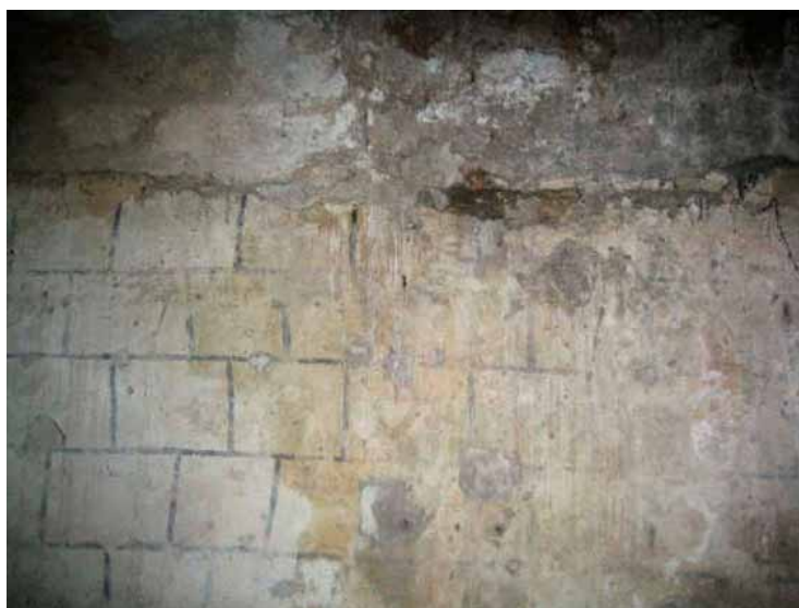
Fig 8 : Faux appareil de la maison forte de Prélian à Saint-Jean-le Chevelu, cl. É. Sirot.
