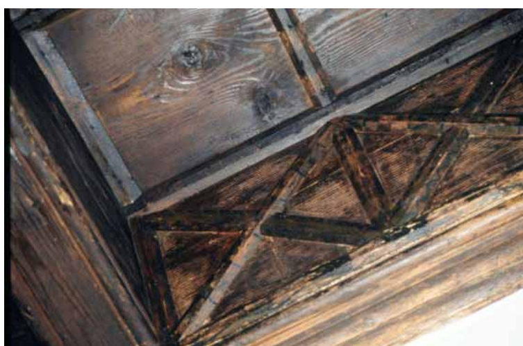
Fig 9 : Couvre-joints du plafond de Plancherine, cl. É. Sirot.
