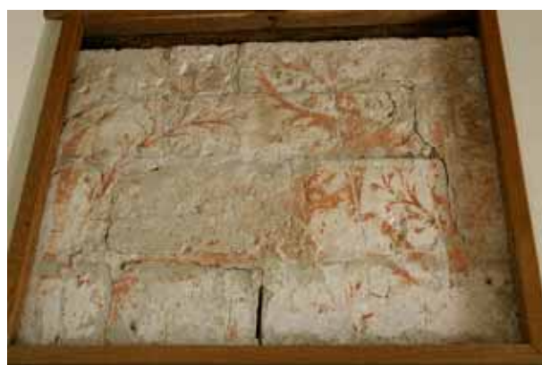
Fig 6 : Largny-sur-Automne, maison des Outhieux, revers du mur en fig. 1 (Cl. G. Victoir, 06-2007).
