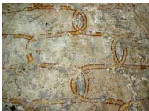
Fig. 9 : Amboise, château, salle souterraine, détail (cl. C. Davy).
