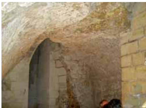
Fig. 8 : Amboise château, salle souterraine : vue partielle (cl. C. Davy).
